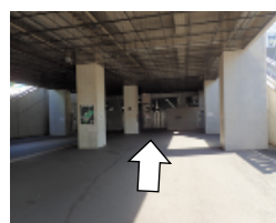
④メインゲート下通路（駐輪場）
